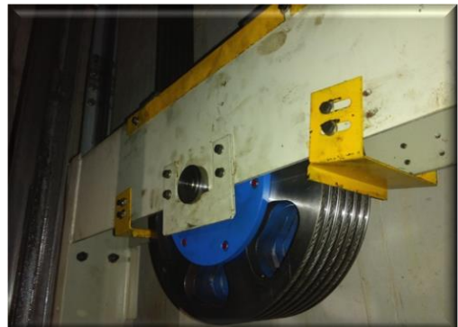
균형추 쪽 "분할 독립 로프폴리" 설치 예(L타입)
