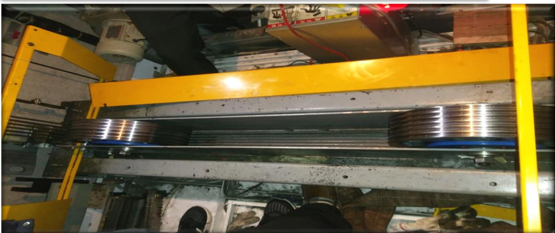
승강기 카 상부 쪽 "분할 독립 로프폴리" 설치 예(L타입)
